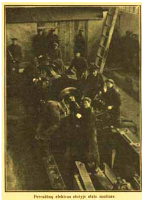
Turbinos montavimas (Technika ir ūkis, Nr. 1, 1929 m.)
