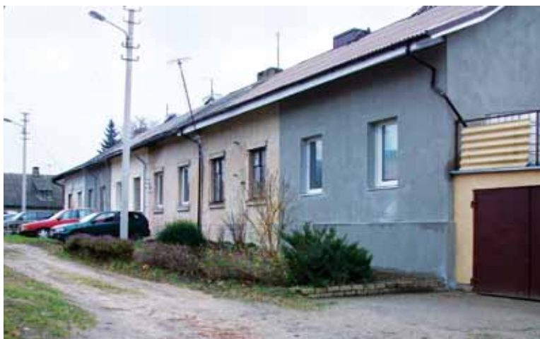
1929–1930 m. elektrinės personalui pastatytas 6 butų namas, 2010-11-11
